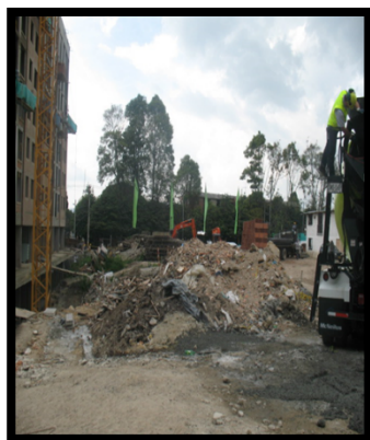
Foto 20 Acopio de escombros mezclados con residuos sólidos, sin protección para el control de emisiones atmosféricas. Visita 20/11/12
