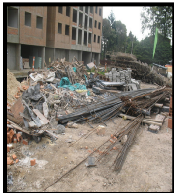
Foto 22. Residuos de Construcción y Demolición mezclados con residuos ordinarios. Visita 20/11/12
