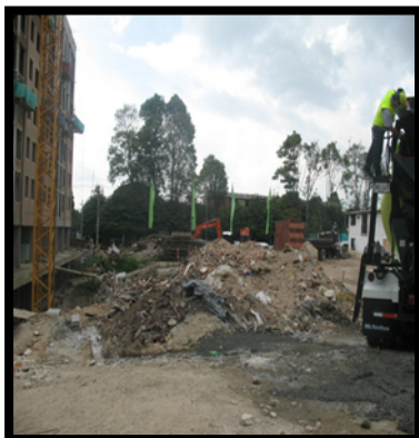
Foto 22. Residuos de Construcción y Demolición mezclados con residuos ordinarios. Visita 20/11/12
